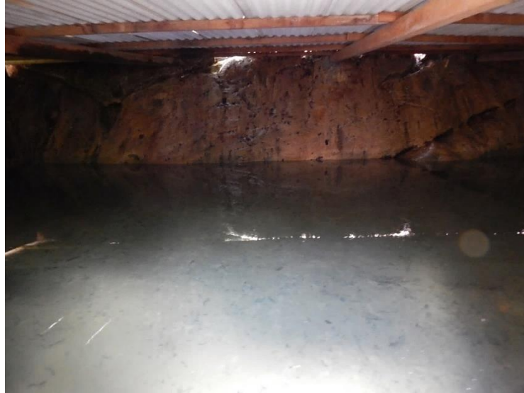
Figura 17- Fonte coberta com telha de fibrocimento.
