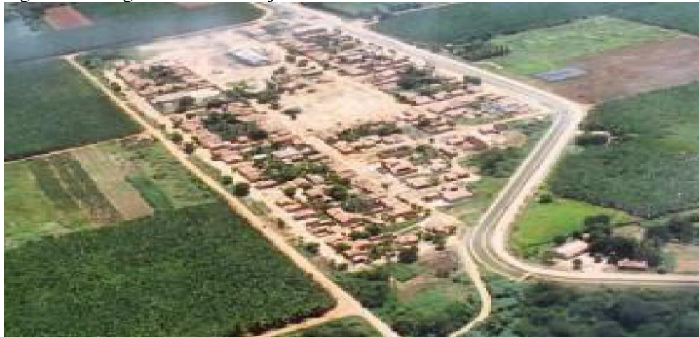
Figura 9 - Imagem aérea do Projeto Formoso - detalhe Vila Setor 33
