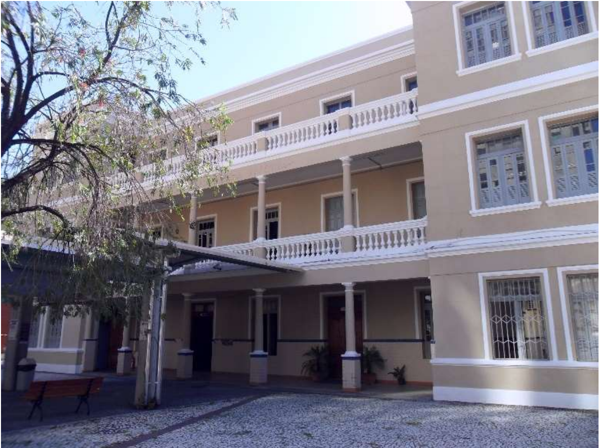
Figura 8 – Vista fachada do complexo onde funciona a Reitoria do IFBA, em 2017
