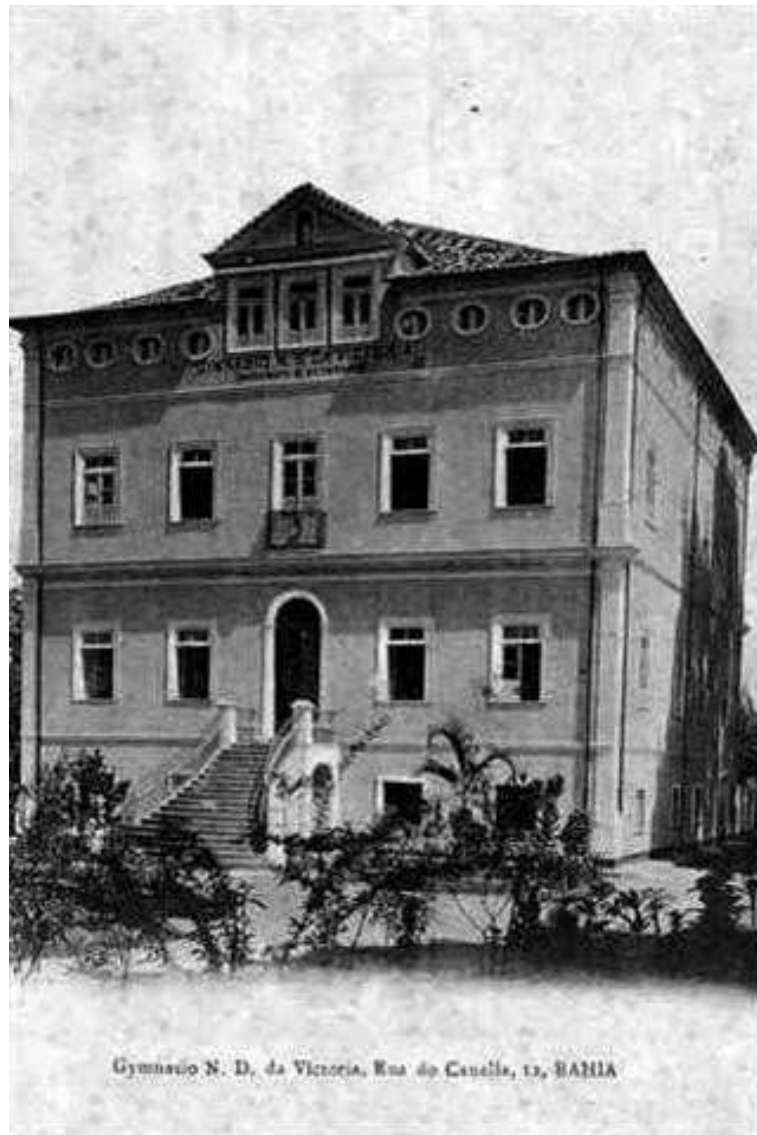
Figura 4 – O edifício após a execução da primeira proposta de ampliação
