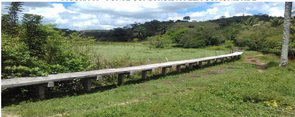
FIGURA 10 - PONTE CONSTRUÍDA PELA COMUNIDADE
