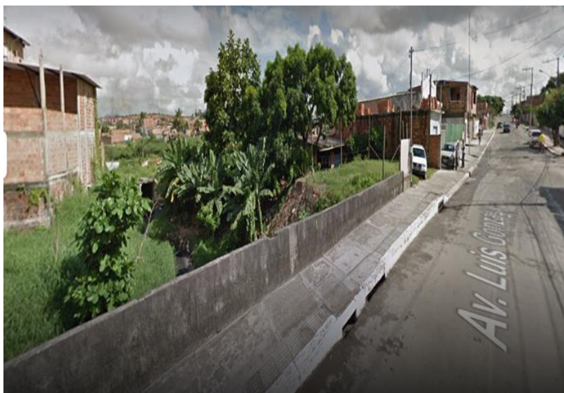
Figura 20 – Casas no entorno do rio Camaçari na Av. Luiz Gonzaga
