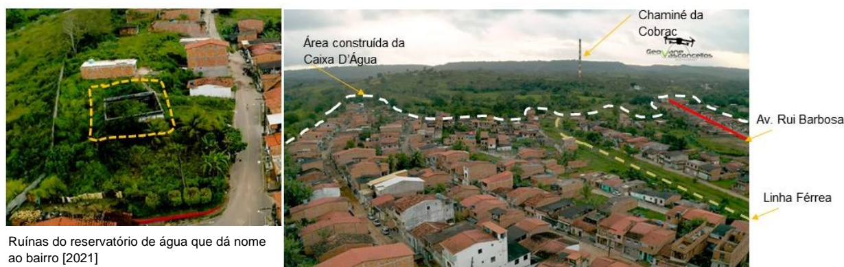
Figura 31 - Vista aérea de parte da Caixa D'água, Santo Amaro, Bahia - 2021
