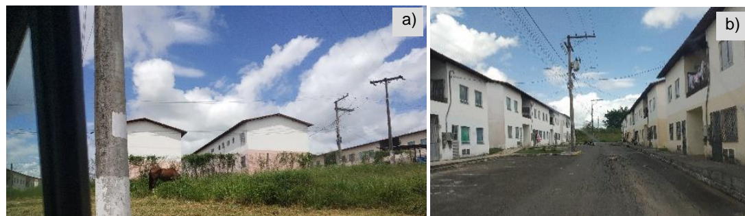
a) edifícios do conj. Solar Paraíso; b) via interna ao conj. Solar Paraíso. Fonte: o autor (2021).
