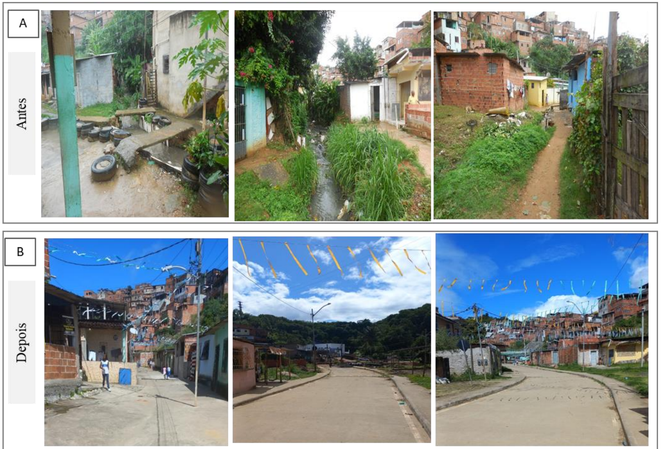
Fig. Sup. 1- Painel fotográfico da intervenção de canalização e tamponamento dos corpos d'água poluídos com esgoto doméstico no vale 3. As imagens em A - Antes da intervenção, B - Depois da intervenção.
