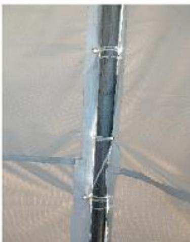
Corda de nylon utilizada sem cortes, com possibilidade de reaproveitamento
