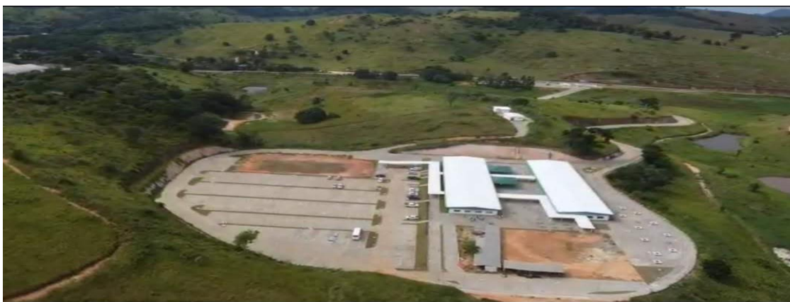
Imagem 2- Vista panorâmica da sede do IFES Campus Barra de São Francisco
