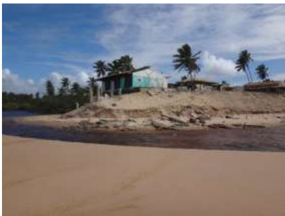
Figura 10: Erosão de barraca de praia devido à migração da foz do Rio Imbassaí.
