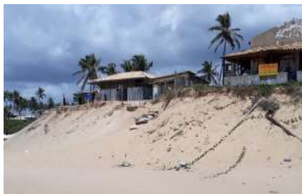
Figura 15: Construções no trecho 2.
