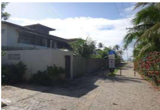
Figura 14: Construções no trecho 1.
