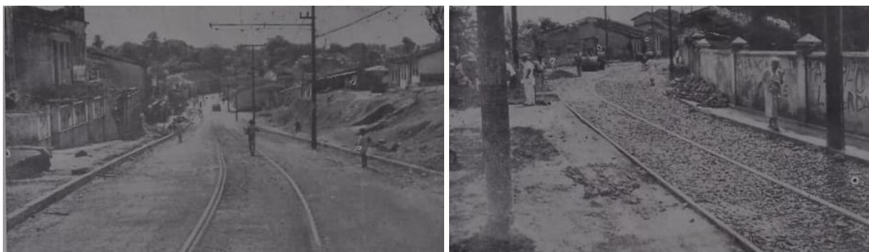
Imagens 28 e 29: Obras de urbanização da Estrada da Liberdade, s/d.
