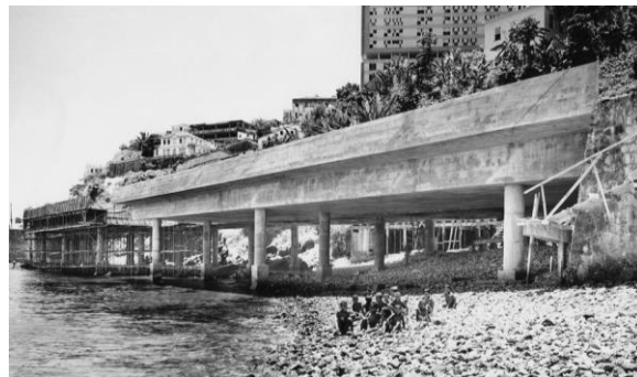
Imagem 21: Construção da Avenida Contorno, s/d.
