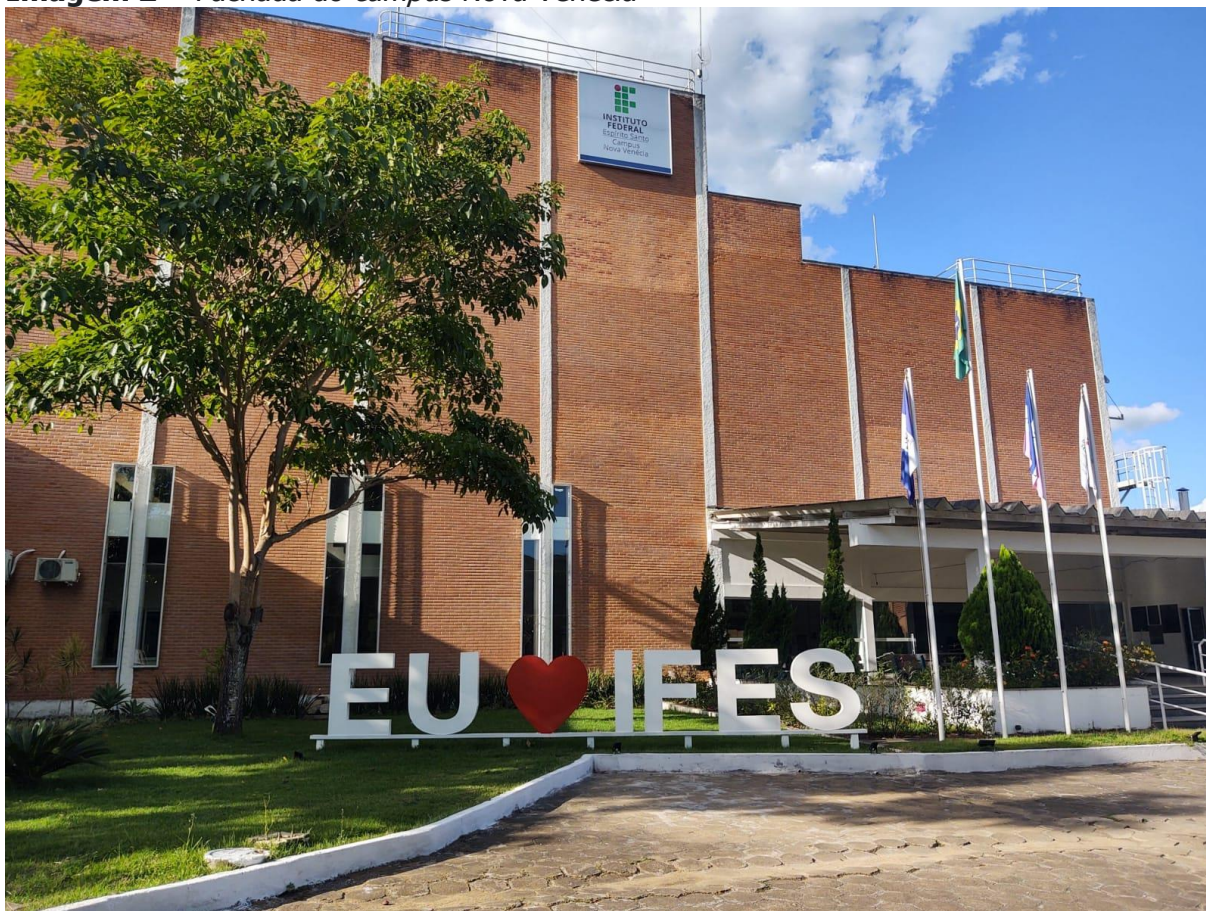
Imagem 2 - Fachada do campus Nova Venécia
