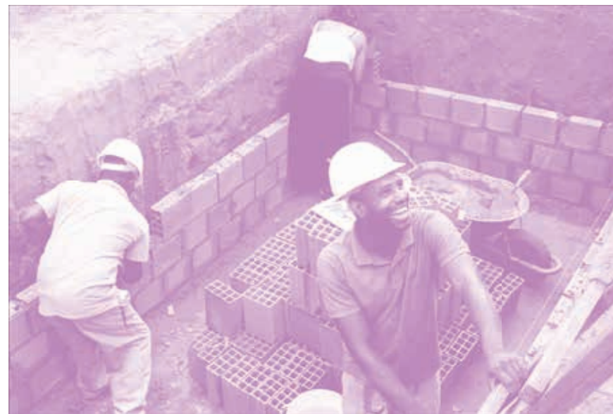
FIGURA 8: SUBINDO AS PAREDES DO TANQUE. FONTE: INSTITUTO GOETHE (2021).
