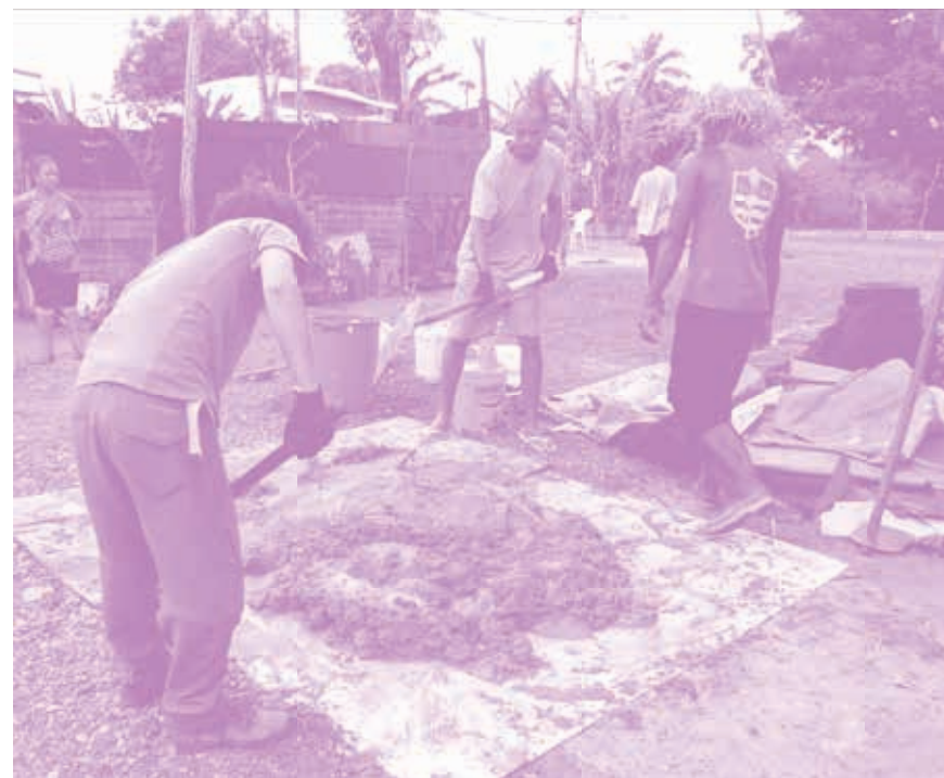
FIGURA 9: FAZENDO ARGAMASSA. FONTE: REPOSITÓRIO DE NÓ(S) (2021).
