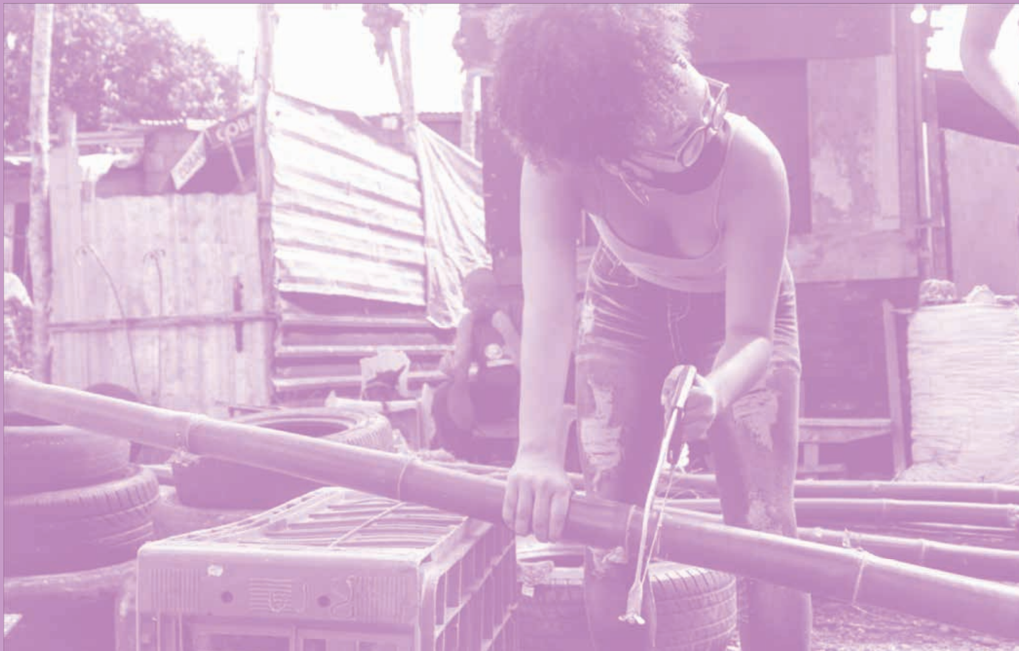
FIGURA 5: LIS CORTANDO BAMBU PARA PAREDE DO BANHEIRO FONTE: INSTITUTO GOETHE (2021).
