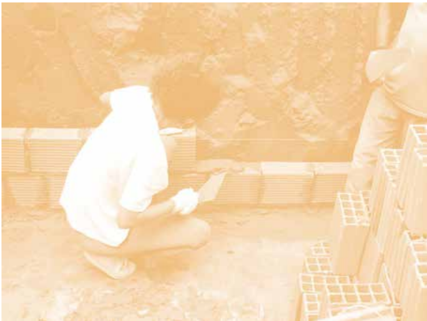
FIGURA 8: KEYLANE NA CONSTRUÇÃO DA FOSSA. FONTE: REPOSITÓRIO DE NÓS(S) (2021).
