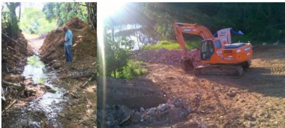
Figuras 26 e 27 - Aterro de rios e nascentes de correntes da Via Metropolitana
