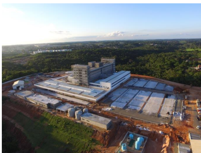
Figura 31 - Obras da construção do Hospital Metropolitano
