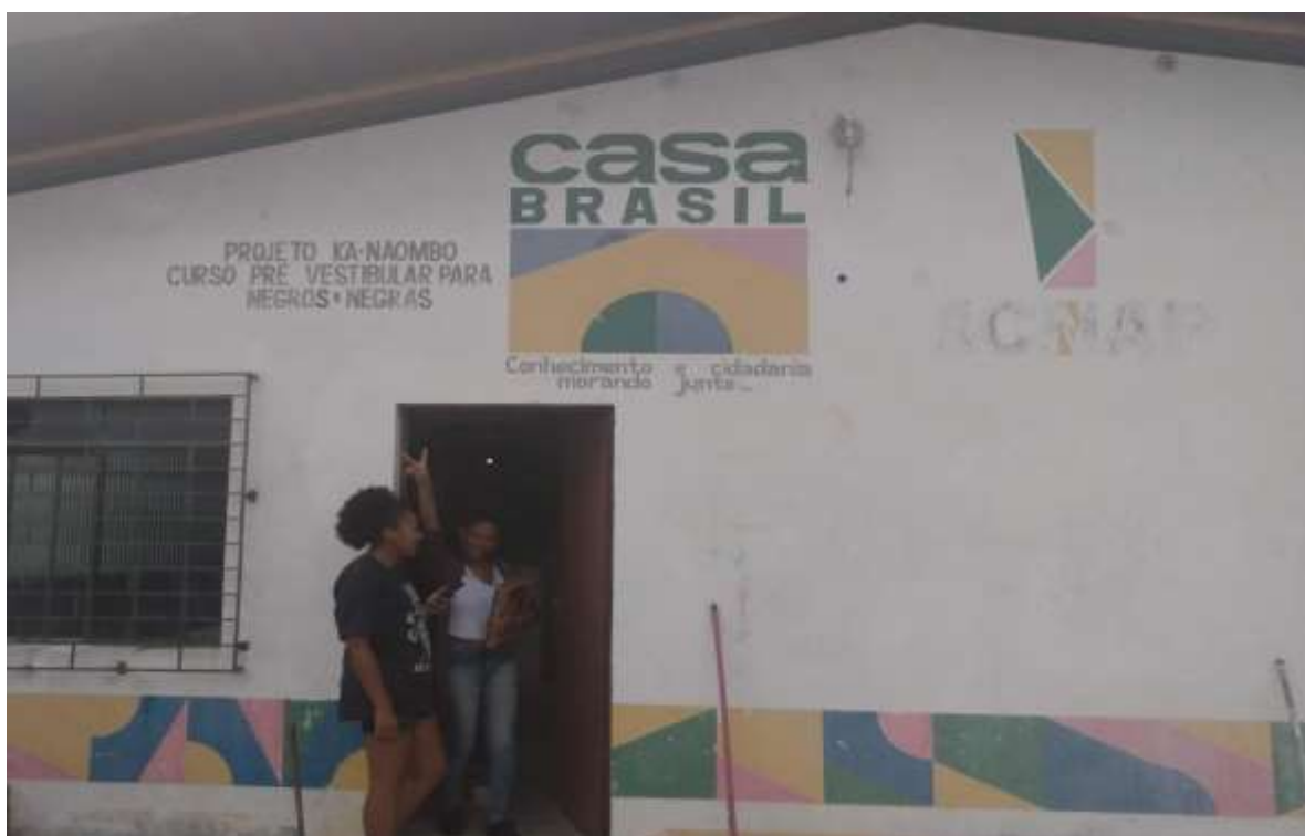
Figura 33: Fachada da sede da ACNAP, registro do mutirão de reforma. Vila Xapinhã, Sítio Cercado, Curitiba- PR, fevereiro/2020.
