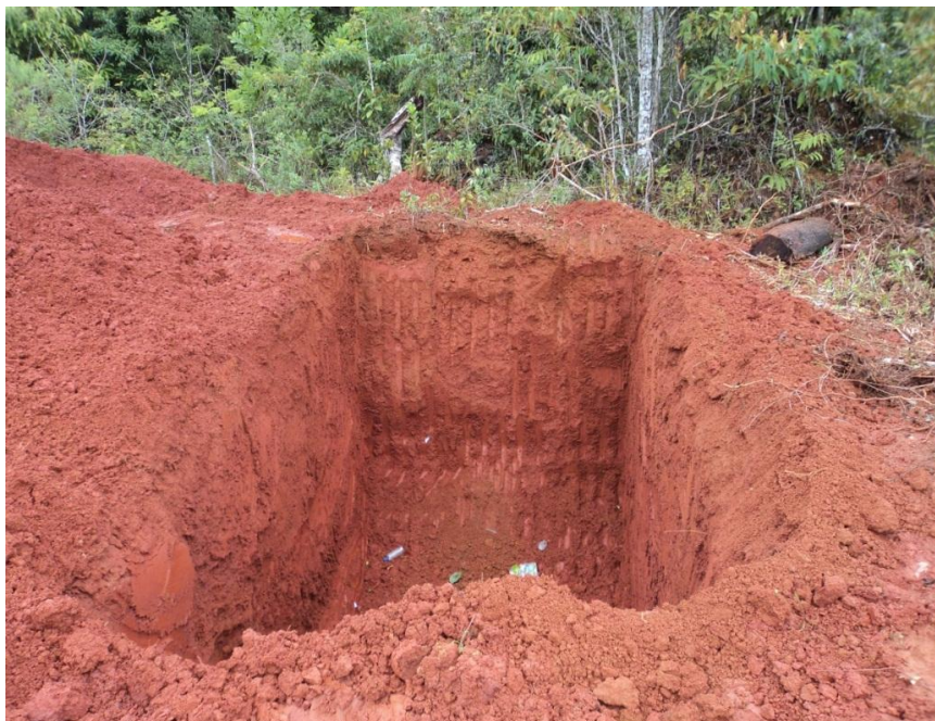
Figura 6 – Exemplo de vala (1/25) no local de disposição final de RS para recuperação ambiental da área degradada. Fonte: Arquivo pessoal (2014).
