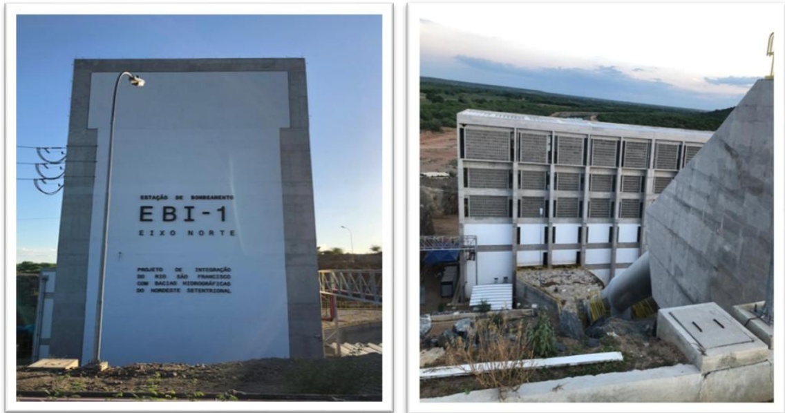
Figura 7 – Estação de Bombeamento: Eixo Norte, Cabrobó-PE
