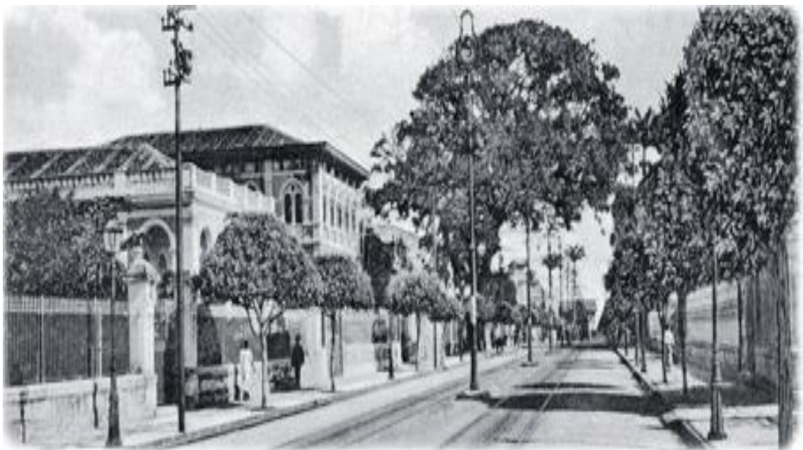
Figura 13 – Corredor da Vitória antes da Reforma
