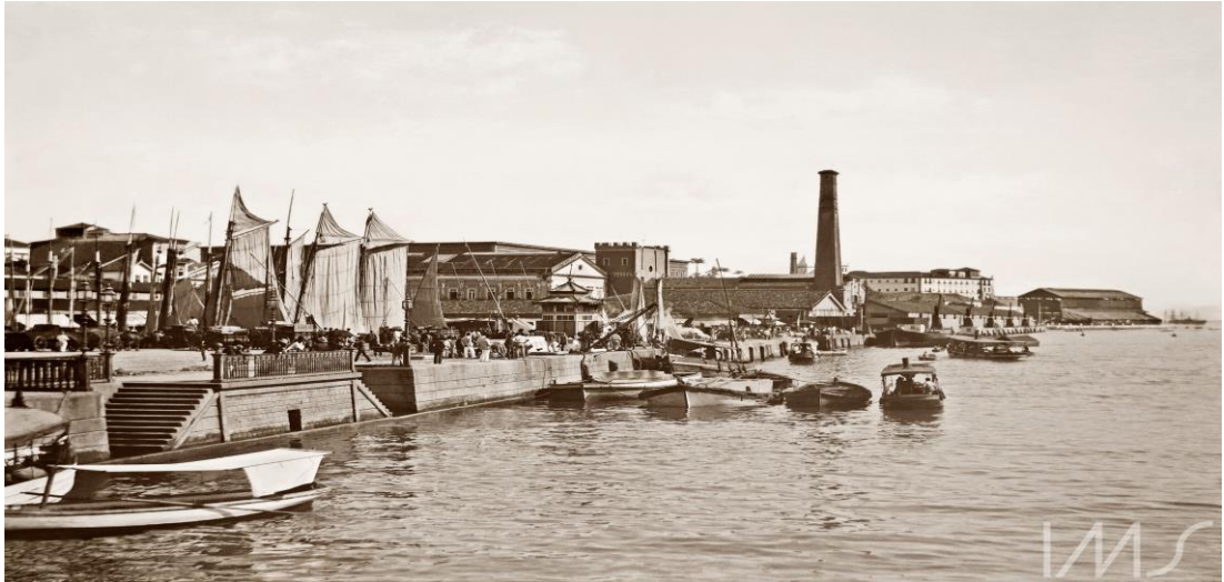
Figura 5 – Cais do Porto após a Reforma de Pereira Passos (RJ)
