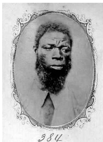
Figura 115 – Casa de Correção da Corte, Rio de Janeiro, c. 1870. Fonte: acervo BN.
