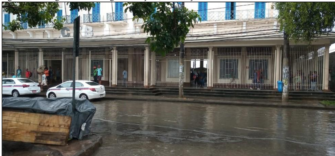
Figura 17 – Alagamento no Largo da Calçada, em março de 2020
