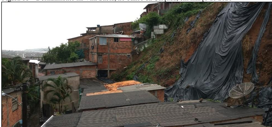
Figura 18 – Deslizamento na Vila Sabiá, no bairro da Calçada, em março de 2020
