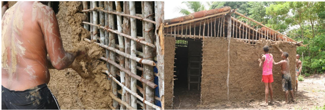
Figura 1. Atividade tradicional de construção das casas - embarreiro na comunidade da Miringaba. Atividade coletiva, onde todos da família e amigos se envolvem em um mutirão de construção. Fonte: Erika de Almeida.
