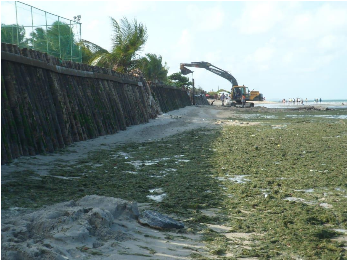
Figura 13- Construção da barreira de coqueiros sobre o estirâncio para a proteção da propriedade particular frente aos processos erosivos
