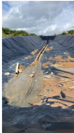
Figura 3 – Foto do CVTR em fase de construção.
