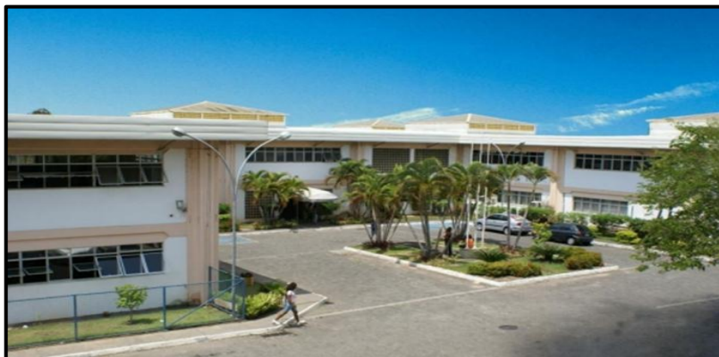
Figura 5 - Sede do Instituto Anísio Teixeira, construída após sua reestruturação, em 1991
