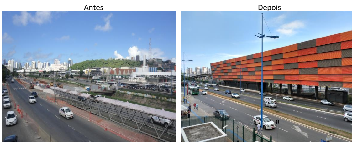
Figura 9 – Salvador: barreira visual formada pela Estação Detran
