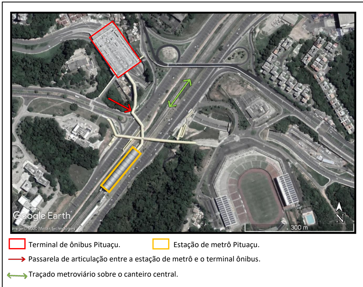
Figura 15 - Salvador: local depois da implantação do terminal de ônibus e da estação Pituauçu
