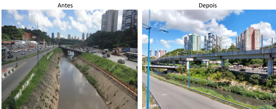
Figura 8 – Salvador: paisagem modificada pela inclusão dos suportes de elevação do metrô
