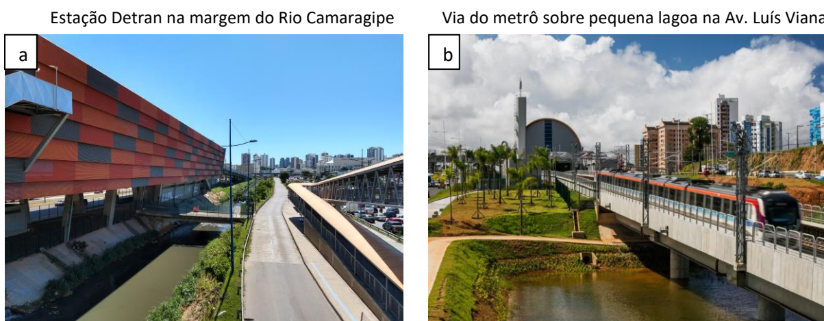
Figura 12 - Salvador: estruturas formadoras do traçado da linha 2 em destaque na paisagem
