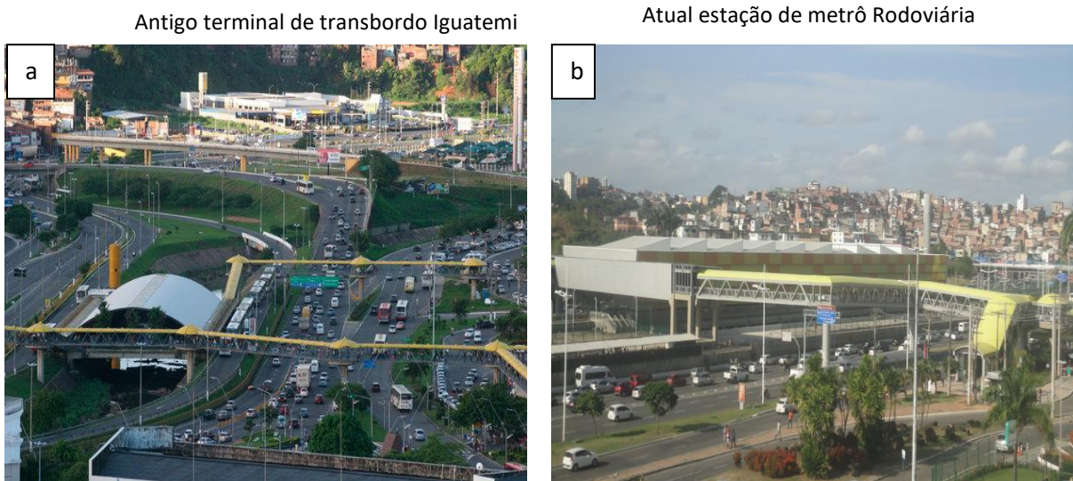
Figura 10 – Salvador: comparação entre o antigo terminal de transbordo Iguatemi e a atual estação de metrô Rodoviária
