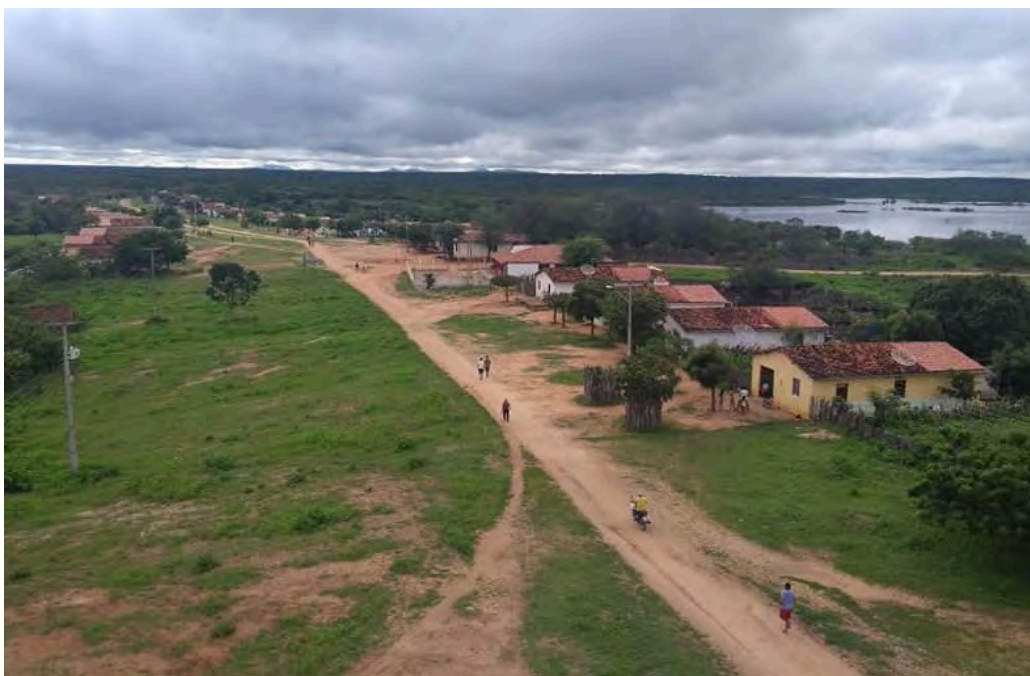
Imagem 1 – A rua central do assentamento Palmares, com as casas em suas laterais, em vista do alto da torre da caixa d’água do assentamento
