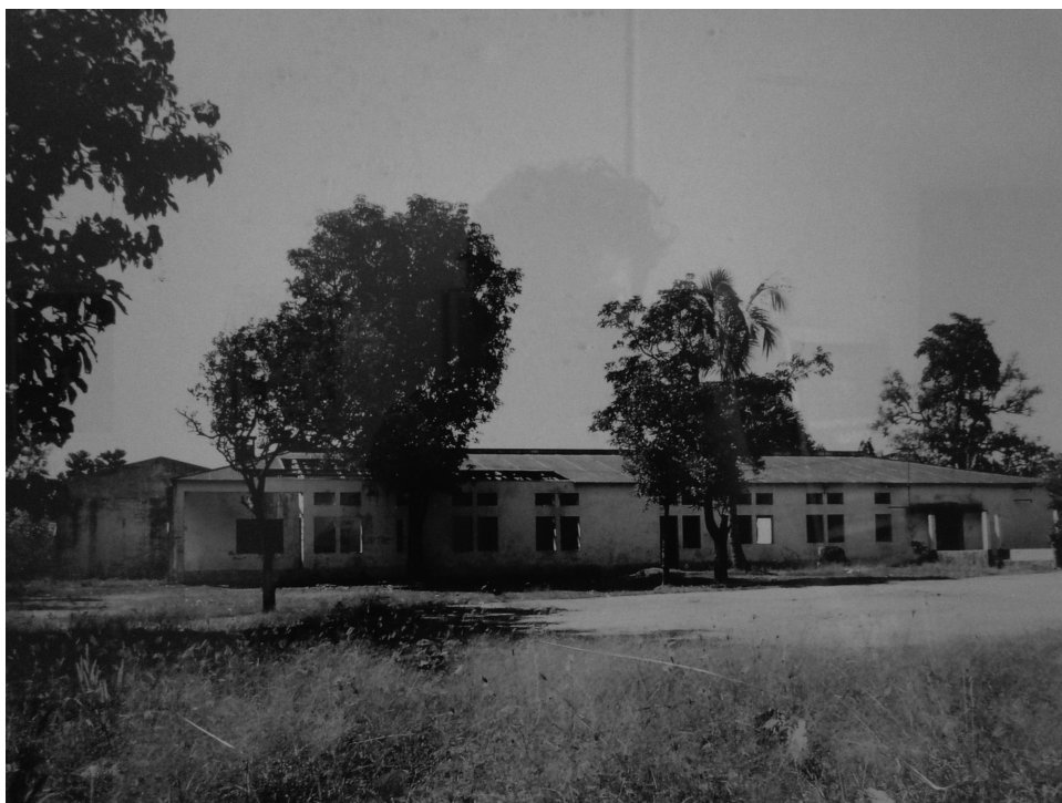
Figura 25. Ruínas da comarca antes da reforma
