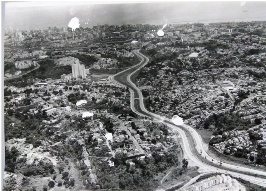
Figura 9: Vale do Bonocô com vista sentido Centro. Bairro de Cosme de Farias (lado direito). Bairro de Brotas (lado esquerdo), 1978
