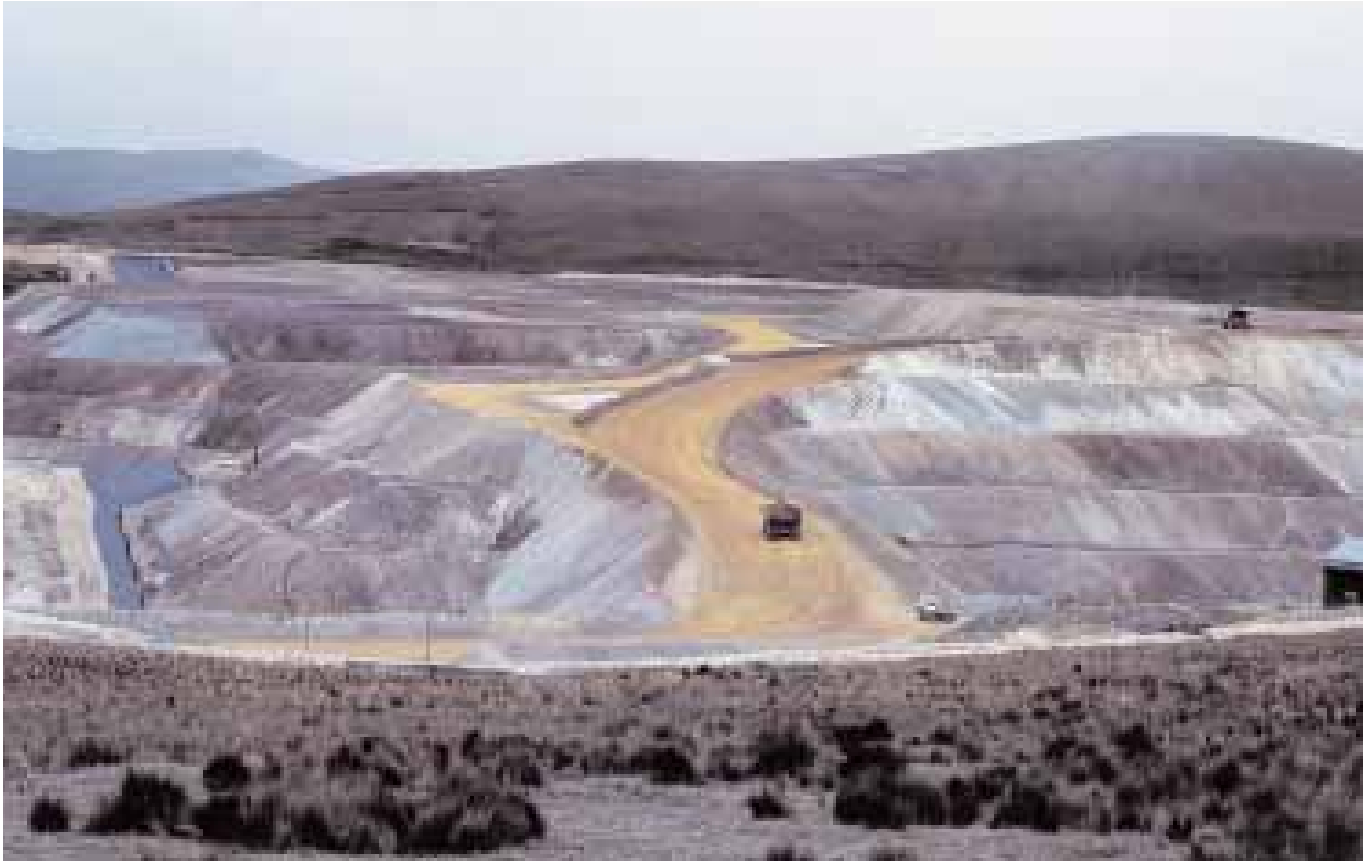
Obras da Mina de Yahanococha: recorde de segurança no trabalho no Peru
