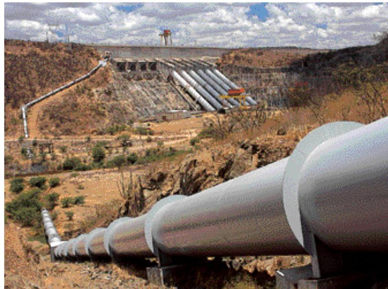
**A caminho: adutora leva água da Usina de Xingó à estação de bombeamento**
