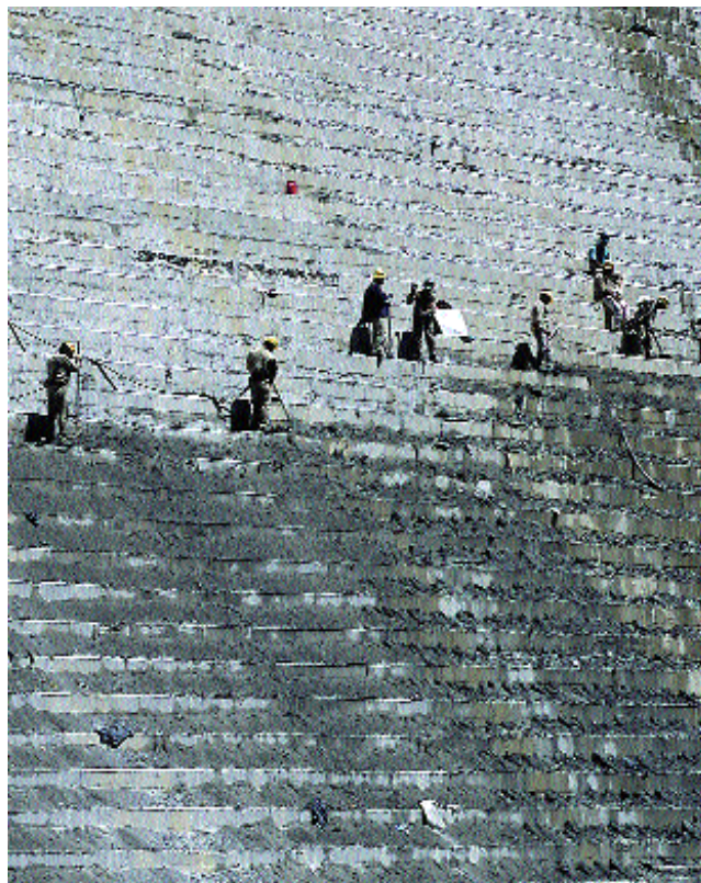
Fornecimento e estocagem de cimento foram alguns dos desafios do empreendimento
