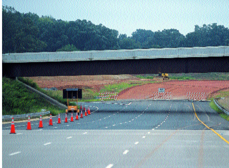
Trecho da I-85: primeira obra da Odebrecht na Carolina do Norte
