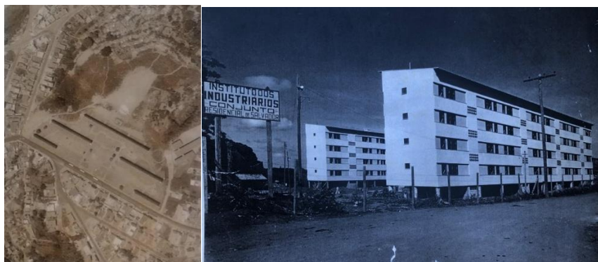
Figura 48: Implantação do conjunto (à esquerda) e imagem da entrada do conjunto em 1949 (à direita).
