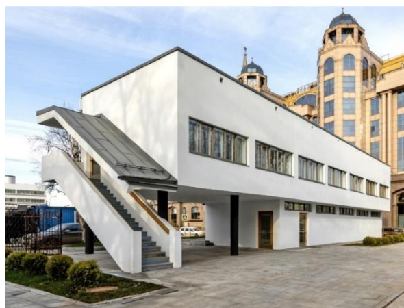
Figura 22: Perspectiva atual da lavanderia coletiva do conjunto Narkomfin.
