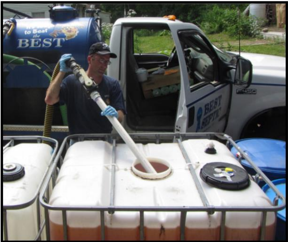
Figura 27 - Bombeamento da urina do tanque de armazenamento usando um caminhão de sucção a vácuo.
