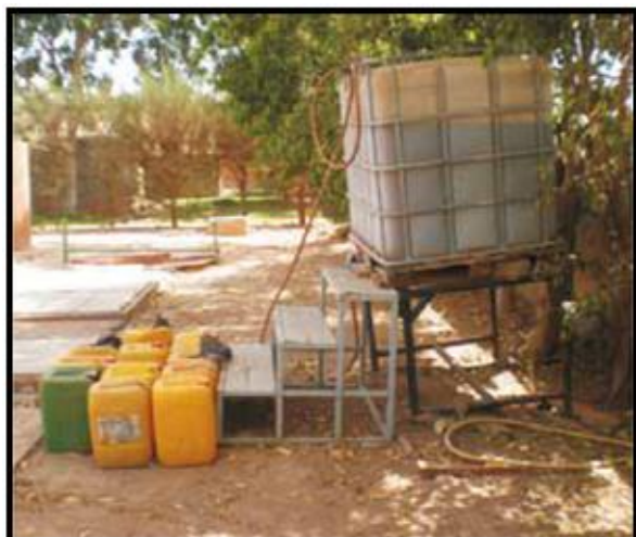
Figura 26 - Armazenamento da urina em pequena escala (tanque de 1 m 3 ) (a) e grande escala (b).
