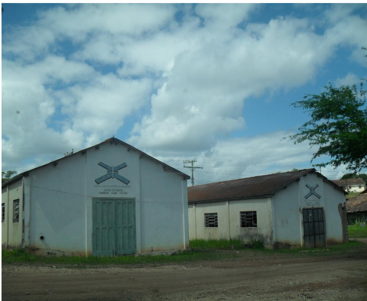
Figura 18 - Faixada frontal de galpões da Fazenda Jequitibá
