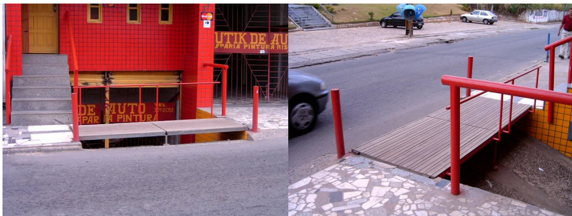
Figura 15 – Passarela na Boca do Rio, Salvador, 2006. Para ter a rampa e aceder á oficina mecânica, o proprietário concebeu uma passarela com duas partes levadiças que permanece habitualmente fechada, abrindo-se pontualmente quando o automóvel entra. Fotos do autor.
