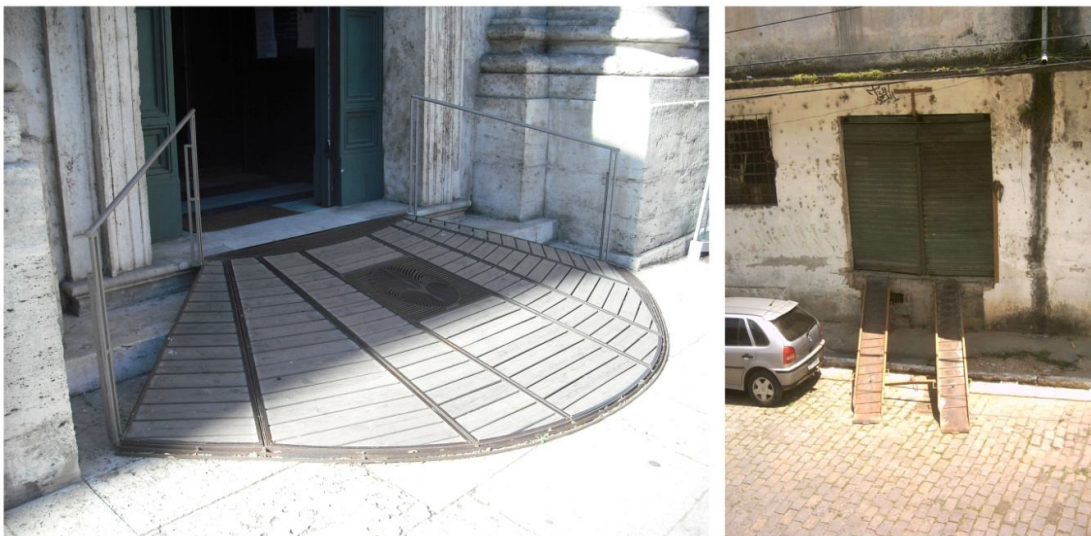
Figura 13 – Rampas. A primeira na Igreja de San Giovanni dei Fiorentini, em Roma, Itália, 2011. Apesar do desenho mais cuidadoso, a segunda, com menos recursos, resolve problema mais grave: o acesso a uma oficina mecânica em altura dispar, calçada estreita, de modo a ser removível, bairro do Pilar, em Salvador, 2006. Fotos do autor.
