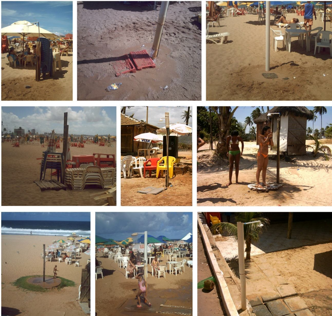
Figura 8 – Progressão de soluções a um mesmo problema, presente no primeiro exemplo: o piso da área "molhada" intrínseca a um chuveiro cujo propósito é retirar o sal e a areia. Salvador, 2006-7. Fotos do autor.
