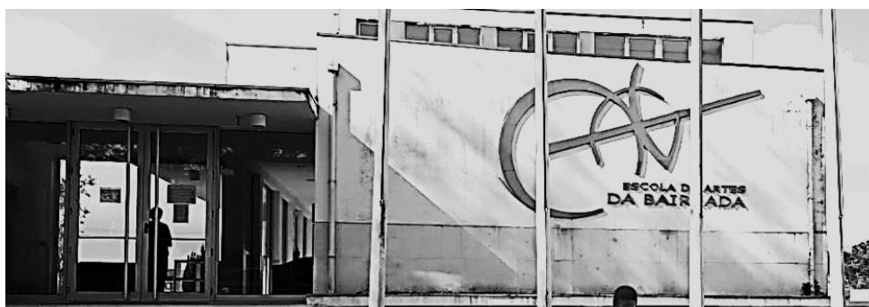
Figura 11: Fachada da EAB
