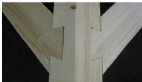
c) encaixe entre peças inclinadas
