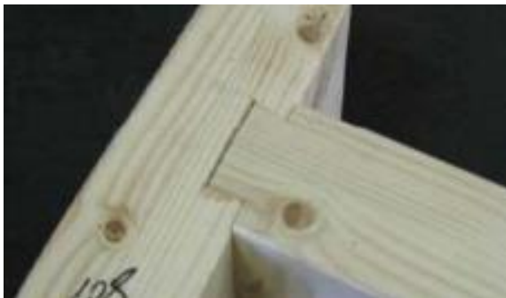
b) encaixe para ligação entre peças ortogonais
