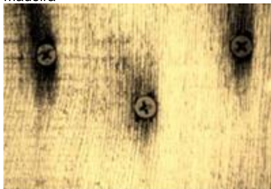
Figura 10 – Degradação de conectores metálicos e formação de manifestações patológicas na madeira
