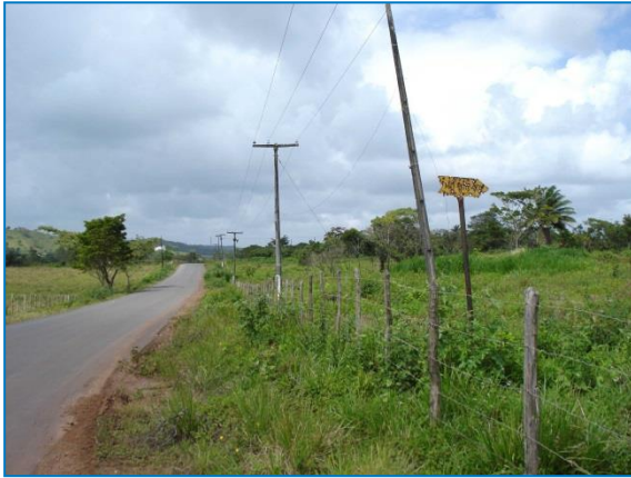
Figura 11 - Vertissolo, com inclinação de postes, em parte devido ao movimento do solo. Fonte: Mapeamento Geoambiental - Ativo Sul, 2009
