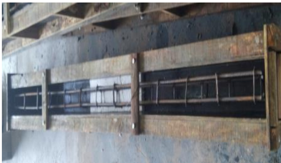
Figura 5.36. Exemplo de placa de EPS na fôrma de madeira.
