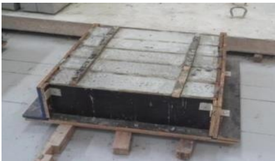
(b) Tiras apoiadas no suporte de madeira
