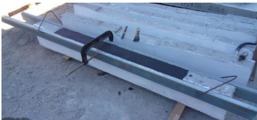
Figura 5.42. Esquema do reparo com argamassa álcali ativada em vigas 210.
