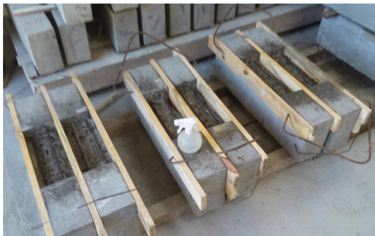
Figura 5.24. Umedecimento do substrato para reparo.
