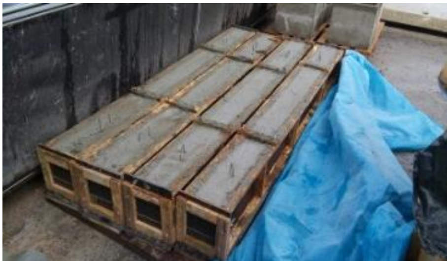
Figura 5.39. Suporte para sustentação da armadura.
