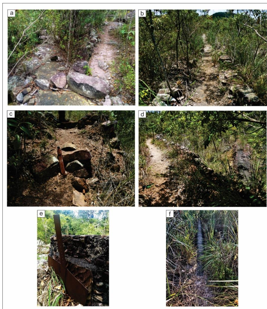
307 Foto 2. a) Muro para captação de água a partir do Rio Capivari; b) Dutos de canalização enterrados; c) Dutos de 308 canalização expostos; d) Bifurcação entre a Trilha e os dutos; e) Comporta de barragem; f) Dutos de canalização. 309 Photo 2. a) Wall for water catchment in the Capivari River; b) Buried ducts; c) Catchment ducts exposed; 310 d) Bifurcation between the trail and the ducts; e) Dam Floodgate; f) Ducts 311
