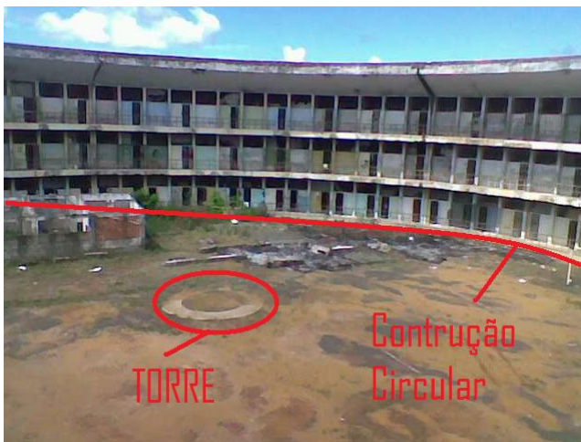
Figura 7 - Penitenciária Lemos Brito- pavilhão desativado
