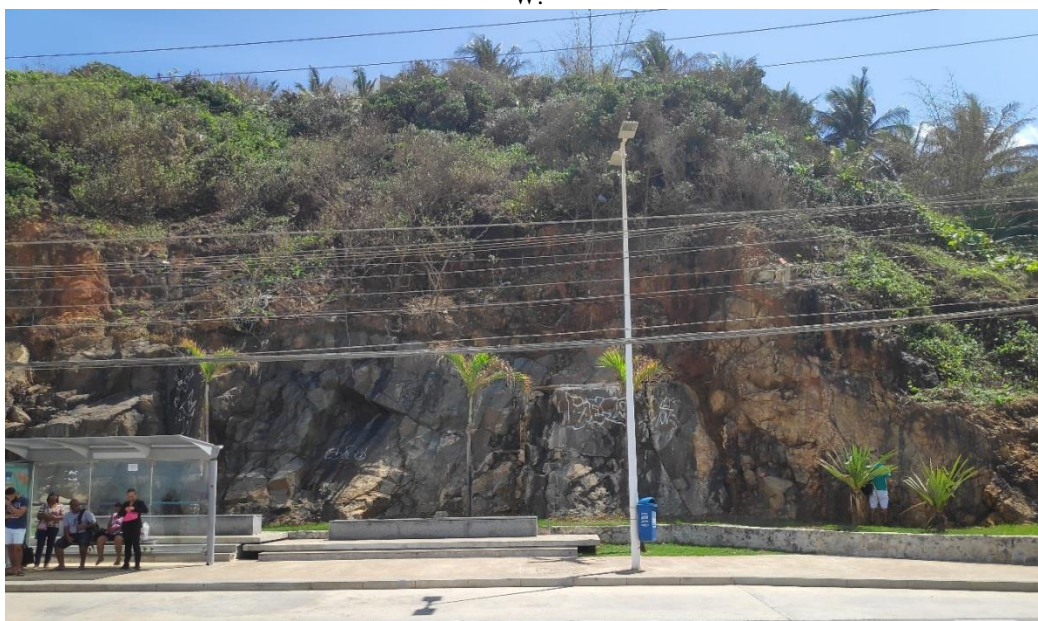
Figura 19. Fotografia do Talude 2, localizado no bairro de Ondina. A orientação da seção é aproximadamente E-W.
