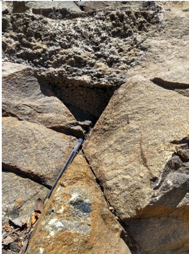
Figura 35. Interseção de rupturas formando uma cunha, Talude 2.
