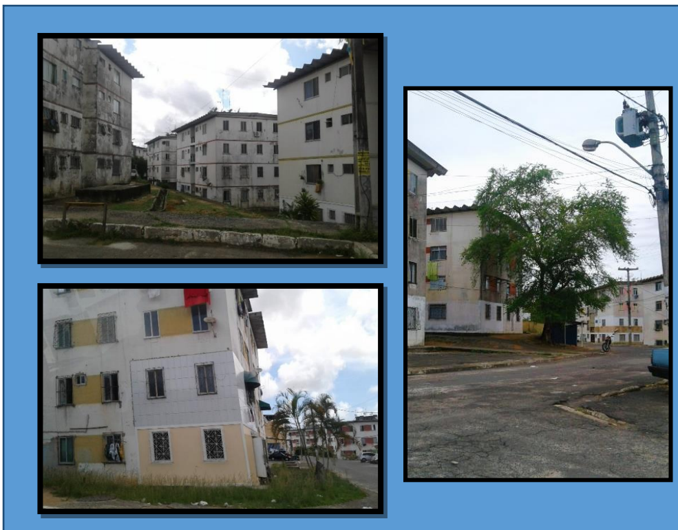
Figura 11 – Fotografias dos prédios do Complexo Residencial Cajazeiras
