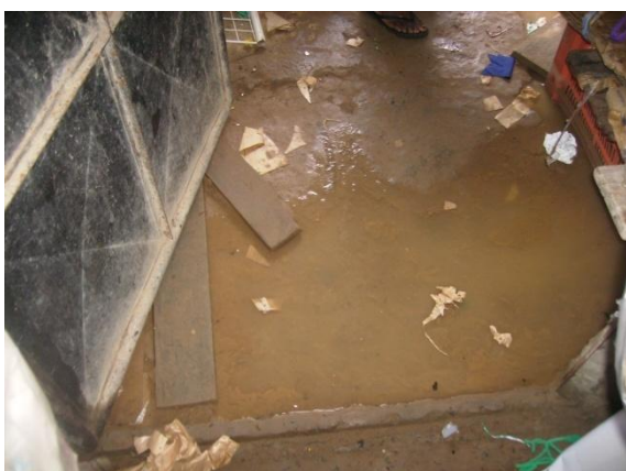
Figura 25: Portão de acesso à área interna.
