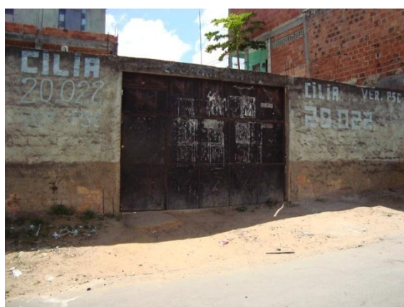
Figura 16: Portão de acesso da sede da Cooperativa.
