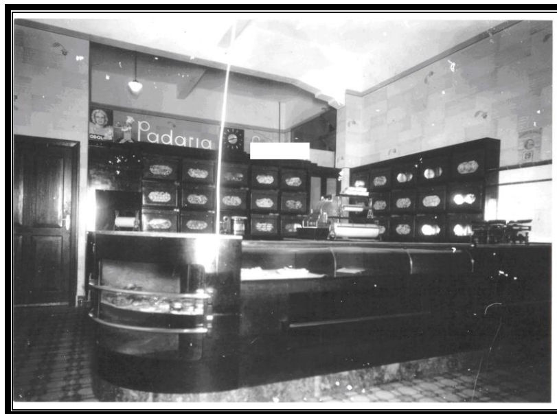
Sala de atendimento – estrutura interna, década de 90
