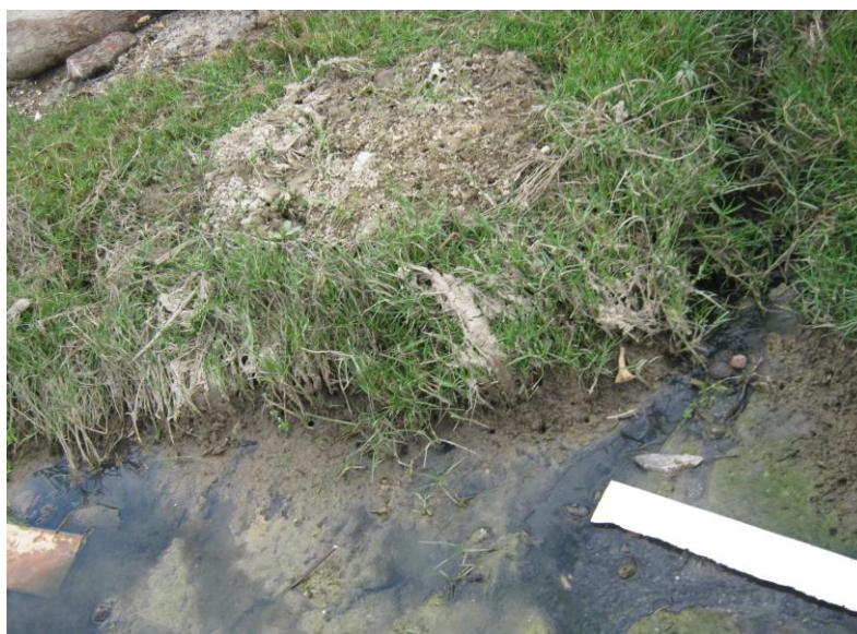
FONTE: Sales, 2011. (Esgoto a céu aberto em Maré)
