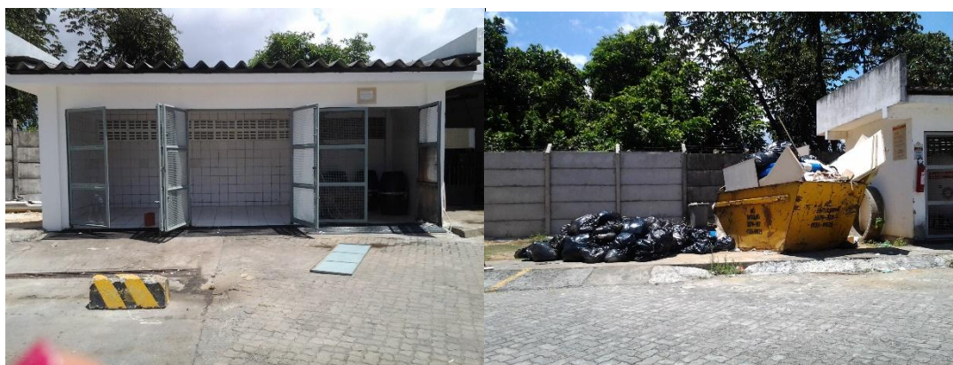
Figura 12: Abrigo e armazenamento externos dos RSS do Hospital Delta
