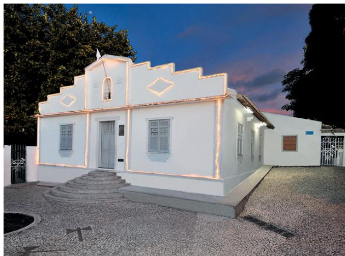
Figura 1 - Entrada do barracão
