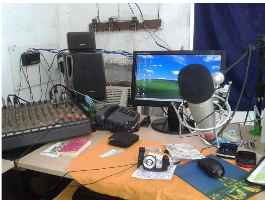
No computador, o locutor busca informações na internet, além de organizar as vinhetas de cada programa. Atrás, vê-se o cabeamento por onde é distribuído o som que chega aos postes.
